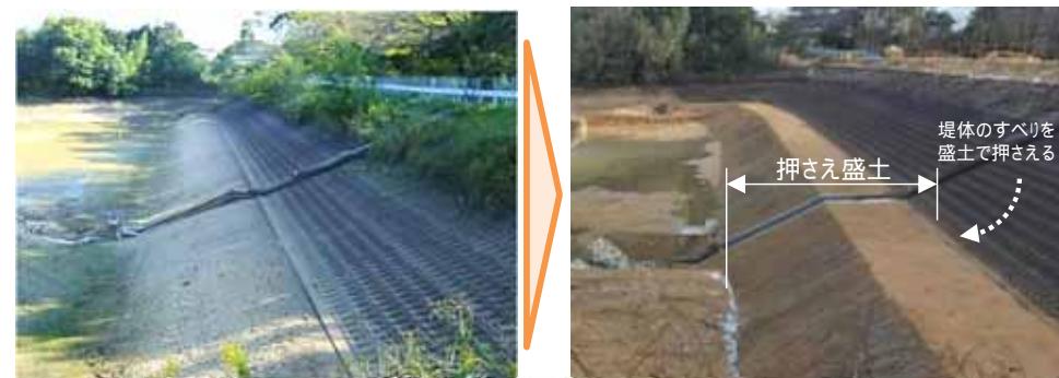
防災重点農業用ため池の耐震化（押さえ盛土による補強）
