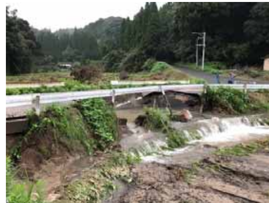
管水路の破裂による営農への影響 （R元.8、鹿児島県鹿屋市）
