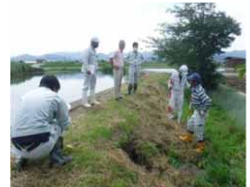
防災重点農業用ため池 の巡回点検
