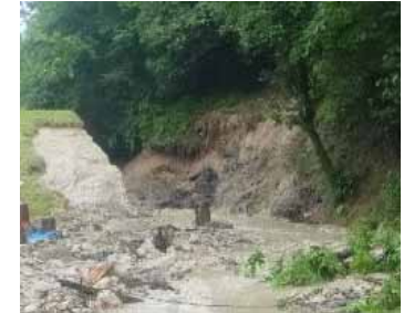
復旧部分が豪雨で再度被災
