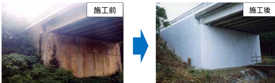
老朽化対策を実施した農道橋
