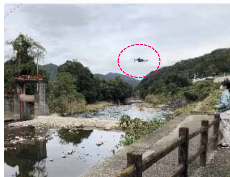
UAV (ドローン) による 頭首工の点検
