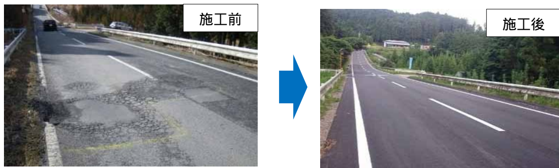
路面改良を実施した農道
