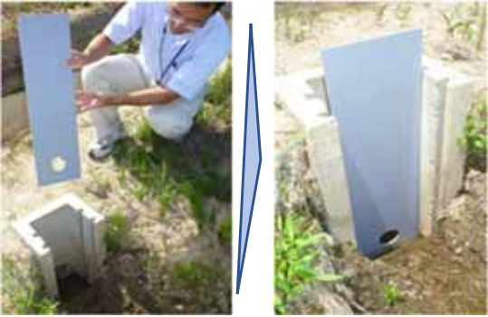
福岡県鯖江市 田んぼダム事業（地域の約8割(1500ha)で実施） （左：調整板設置状況、右：排水柵（調整板挿入））
