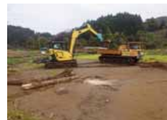
農地への堆積土砂・流木撤去
