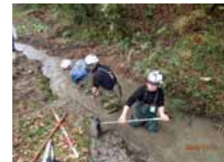
人力による堆積土砂撤去
