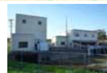
排水機場の監視・制御
