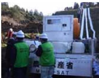
ため池における排水ポンプ設置
