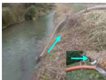
仮設ポンプ設置
