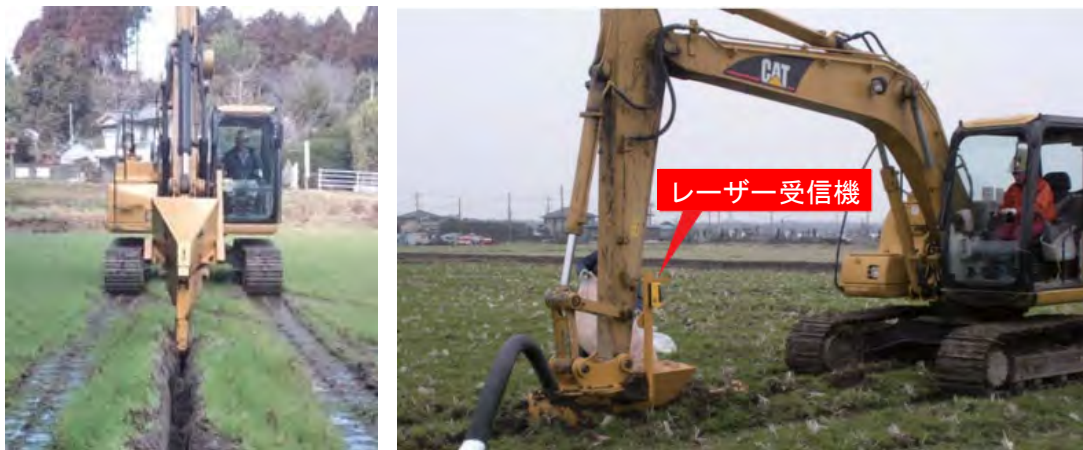
12 13 写真-5.3.2 非開削式暗渠工法（アーム式ベストドレーン工法）の作業状況
