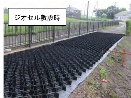
7 8 図-3.4.10 ジオセル（ジオセンチックスの一つ）による舗装の例 4)
