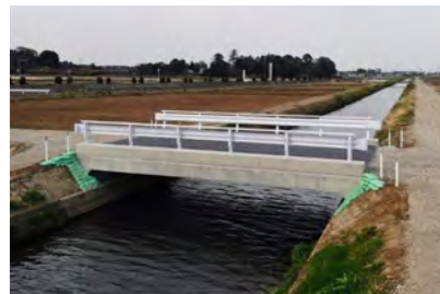
写真-3.4.2 水路横断工として門形カルバートを用いた事例
