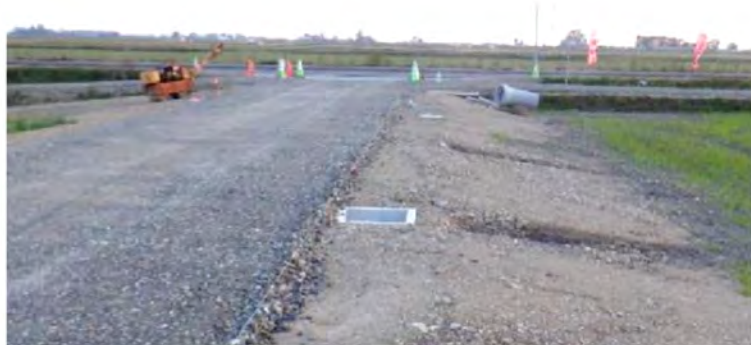
写真-3.4.1 埋設した給水栓 7)
