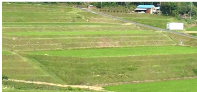
写真-3.3.1 地被植物（グランドカバー・プランツ）によって畦畔法面を被覆した事例
