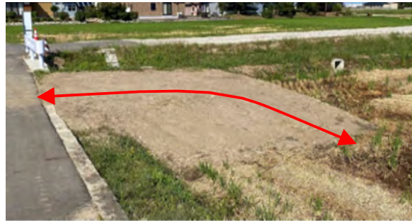
図-3.3.22 クランク型の進入路事例（上図は走行シミュレーション）
