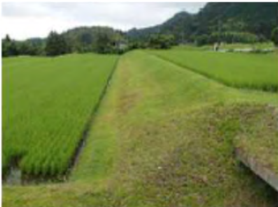
23 図-3.3.16 長大法面の緩勾配化の事例（法面中段の小段がある場合）
