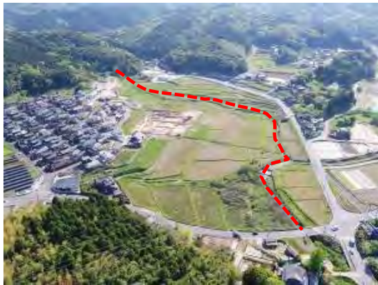
22 整備前 (赤線に大きな傾斜あり)
