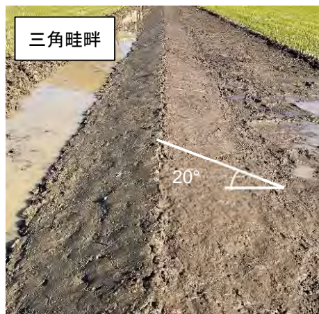
図-3.3.12 リモコン草刈機に対応した畦畔断面 4)
