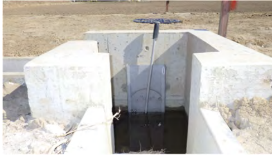
写真-3.7.1 既設水路と管路接続部のゲート
