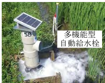
21 写真-3.10.1 ほ場水管理システムの導入事例 22 23
