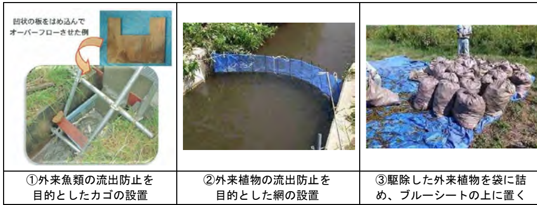
図-4.1.7 外来生物の流出防止対策の例 14,15)
