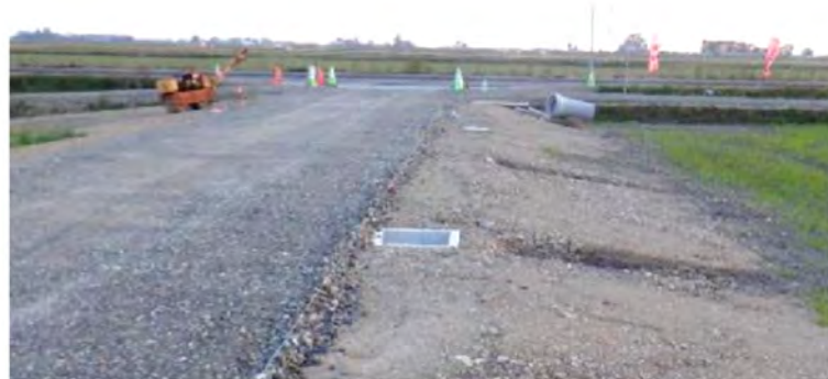
写真-4.4.1 埋設した給水栓 7)
