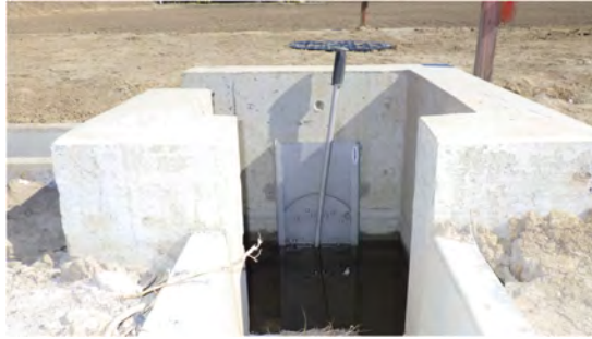
写真-4.7.1 既設水路と管路接続部のゲート
