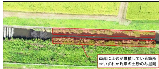
実証区間の二面装工区間
