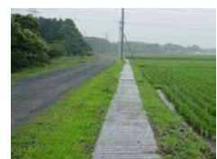
蓋が設置された水路
