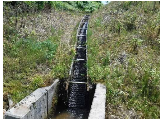
波付フリュームの設置状況
