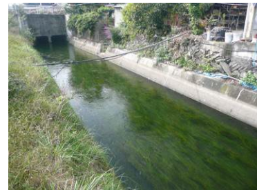
環境配慮対策実施後の水路
