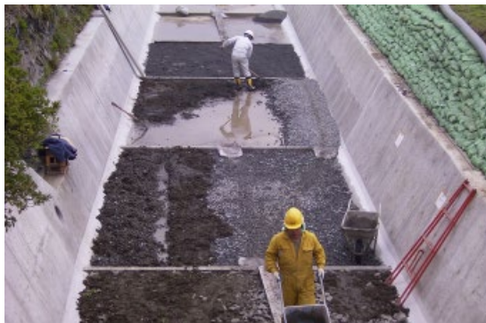
環境配慮対策施工状況
