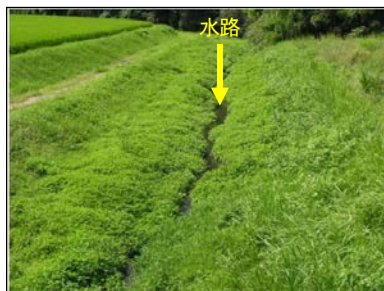
現況水路保全区間
