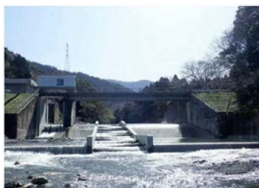
頭首工（改修後）
