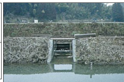
幹線排水路との連続性を確保
