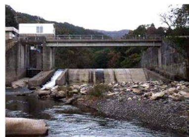
頭首工(改修前)
