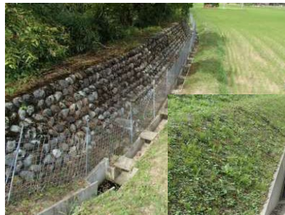
蓋版工の状況
