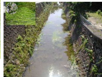
事業実施前の水路
