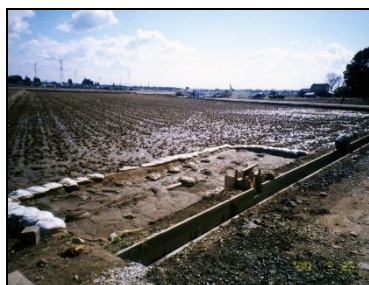
水田を借り入れ沈砂池として利用
