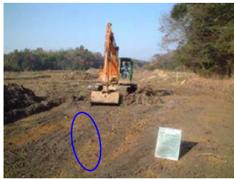
現況表土埋め戻しまでを実施
