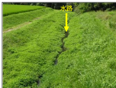
現況水路保全区間
