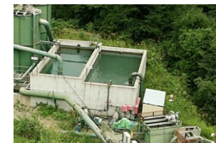
③濁水処理とポンプによる通水
