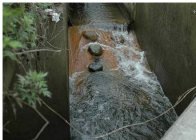
改良された魚道（片斜面粗石付き魚道）
