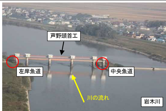
芦野頭首工の状況
