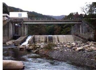
頭首工(改修前)
