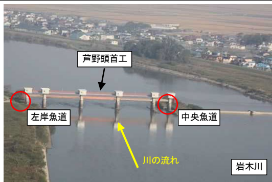
芦野頭首工の状況
