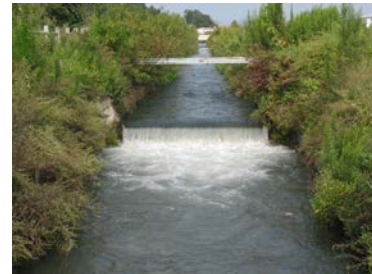
現況の状況 (落差工により、 魚類等の移動経路が分断されていた。)
