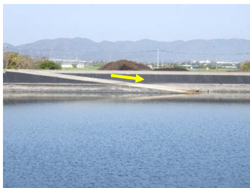
施設内へ下りるスロープの設置例
