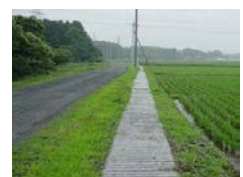
蓋が設置された水路
