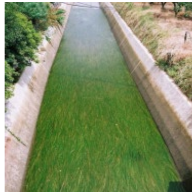
環境配慮対策施工後の水路
