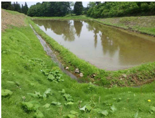
「江」の設置状況
