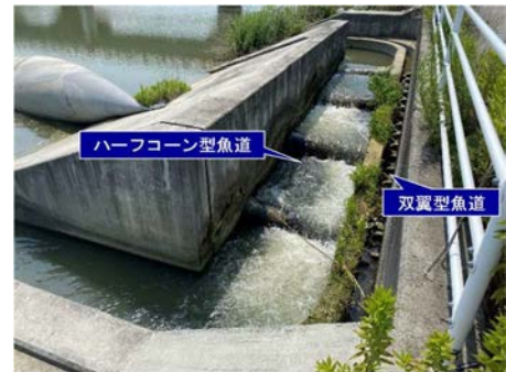
堰樋堰に設置された魚道
