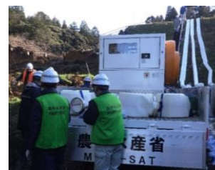
ため池における排水ポンプ設置
