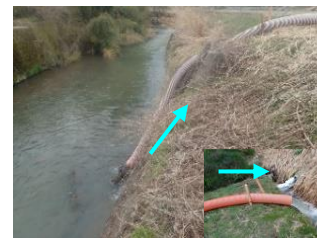
仮設ポンプ設置
