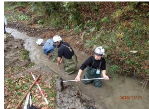
人力による堆積土砂撤去
