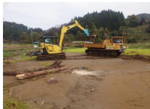
農地への堆積土砂・流木撤去
