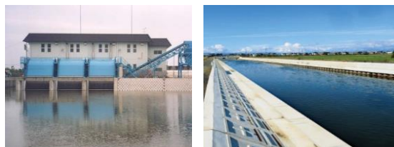
排水機場、排水路の整備
