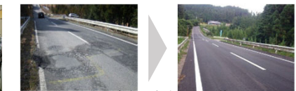
路面改良を実施した農道
