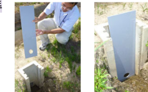
調整板設置状況 排水柵（調整板挿入）（福井県鯖江市）
