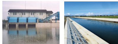
排水機場、排水路の整備
