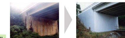
老朽化対策を実施した農道橋
