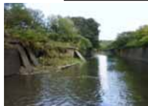
側壁が倒壊した用水路
