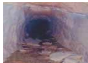
ライニングが崩壊した水路トンネル
