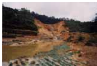
堤体が決壊し漏水したため池
