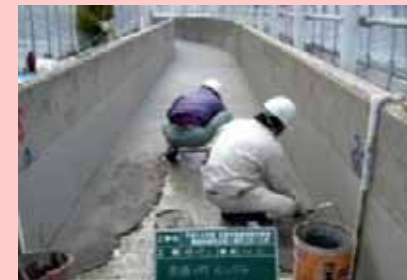
ポリマーセメントモルタルによる補修
