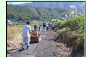
砂利舗装をアスファルト舗装へ
