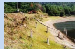
←老朽化の状況 堤体の侵食が 著しいため池
