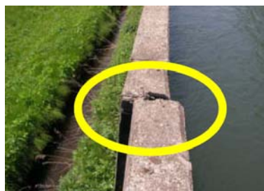
写真 25. 継目のずれ
