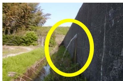
写真 26. 目地の損傷による漏水
