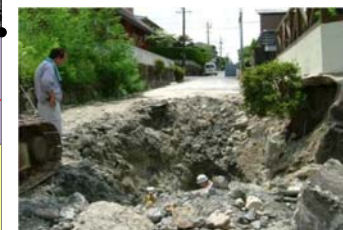
P C管漏水事故により 民家の塀が壊れる被害
