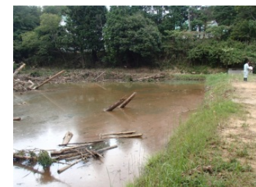
堤体には大きな損傷なし
