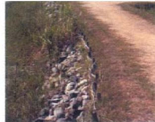
自然材料を用いたため池護岸
