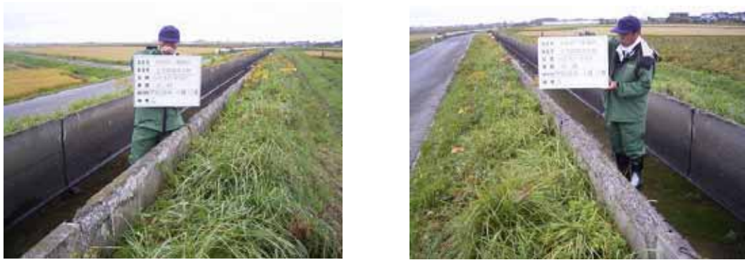
図-2.2 総合評価S-3の開水路
