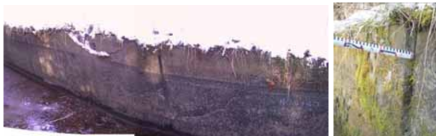
図-2.1 総合評価S-2の開水路
