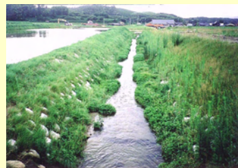
水路改修に当たり、石積護岸による水性生物の生息環境の回復
