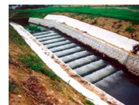
魚類等の移動経路を確保する階段式落差工
