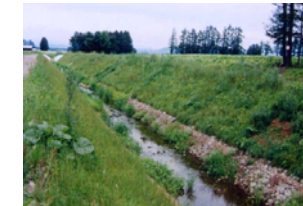
フトン簀護岸により植生を維持し、水生生物に配慮
