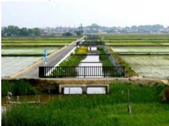
写真-15. 1745 多自然型排水路設置状況
