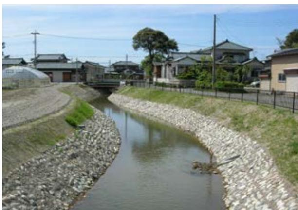
写真-15. 1513 緩勾配型自然石付金網護岸工設置状況
