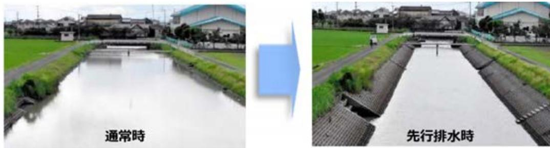
図-16.13 クリーク先行排水による空き容量確保の事例
