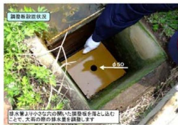
写真-16.1 調整板設置状況
