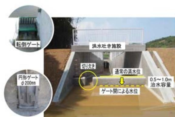
図-16.11 洪水吐き放流ゲート等の設置
