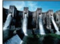
豊稔池は、現存する日本最古の石積み式マルチプルアーチダムである。大正15年から4年の歳月と延べ15万人の労力を投入して完成し、今日も築造当時の勇壮な姿のままに洪水調節とかんがいの貯水機能を果たしている。
