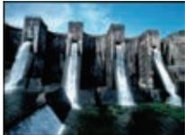
豊稔池堰堤は、現存する日本最古の石積み式マルチプルアーチダムである。大正15年から4年の歳月と延べ15万人の労力を投入して完成し、今日も築造当時の勇壮な姿のままに洪水調節とかんがいの貯水機能を果たしている。
