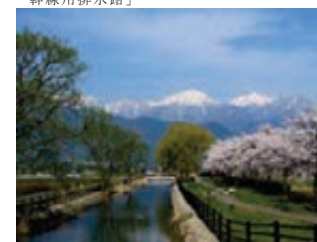
〔自然石模様の型枠ブロックを採用した幹線用排水路〕
