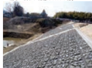
〔堤体護岸に自然石を使用し周辺の自然景観との調和に配慮したため池〕
