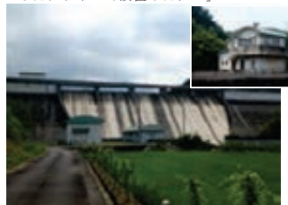
〔管理棟等建屋の屋根形状及び色彩を統一したデザインで設置したダム〕
