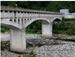
〔デザインに配慮した水路橋〕
