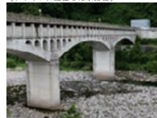
〔デザインに配慮した水路橋〕
