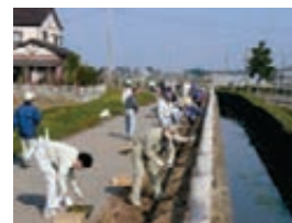
整備後（東2号幹線用水路管理用道路）
