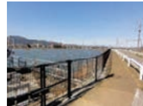
〔鋼製フェンスに更新した管理用道路〕
