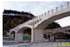
整備中(新橋、旧橋)
