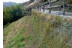
〔緑化が図れる補強盛土壁工〕
