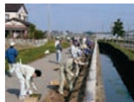
整備後（東2号幹線用水路管理用道路）
