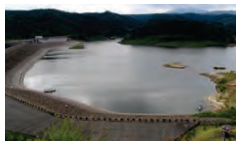
整備後 11年経過
