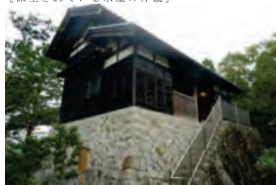
〔保全されている水屋の外観〕
