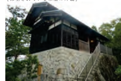
〔保全されている水屋の外観〕
