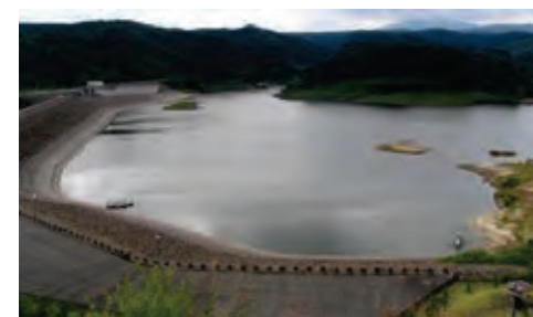
整備後 11年経過
