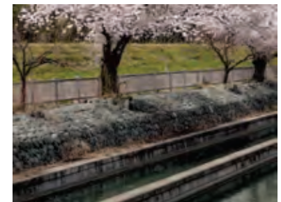
〔三波石を用いた護岸〕
