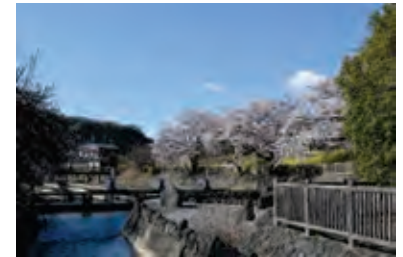
〔三波石を用いた護岸〕
