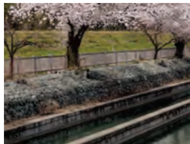
〔三波石を用いた護岸〕
