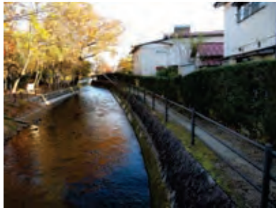
[土系舗装が施された歩道（管理用道路）]
