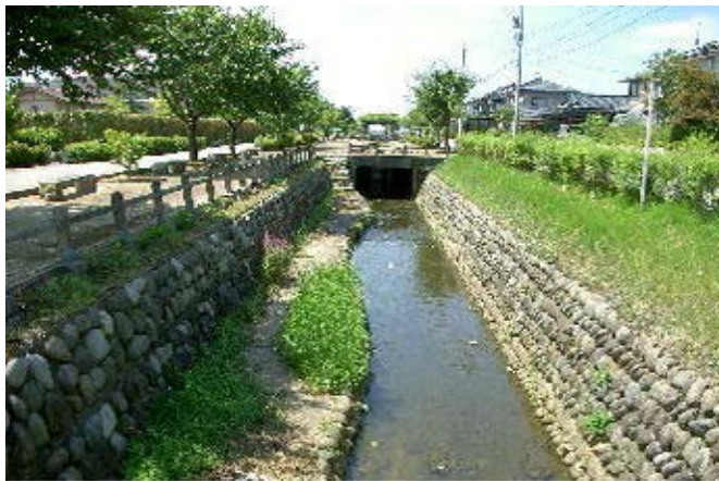
写真-15.5 事業実施後の排水路
