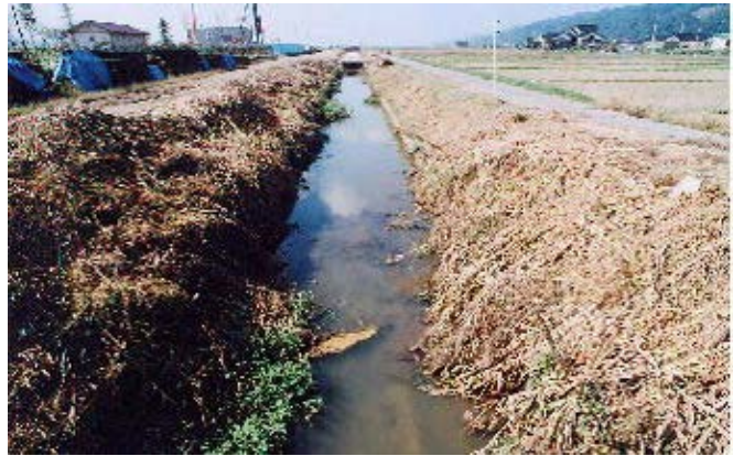
写真-15.4 事業実施前の排水路
