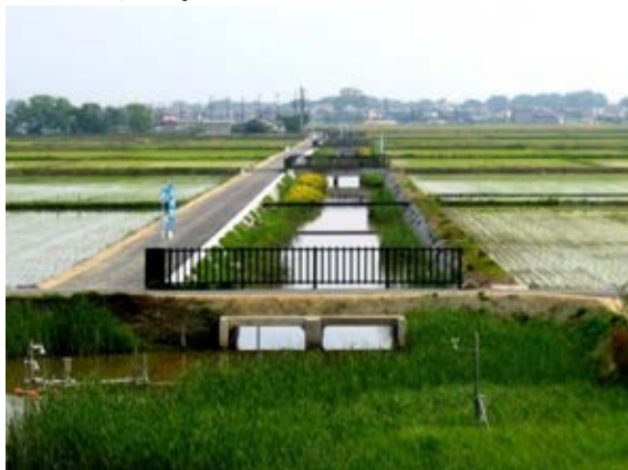
写真-15. 1745 多自然型排水路設置状況
