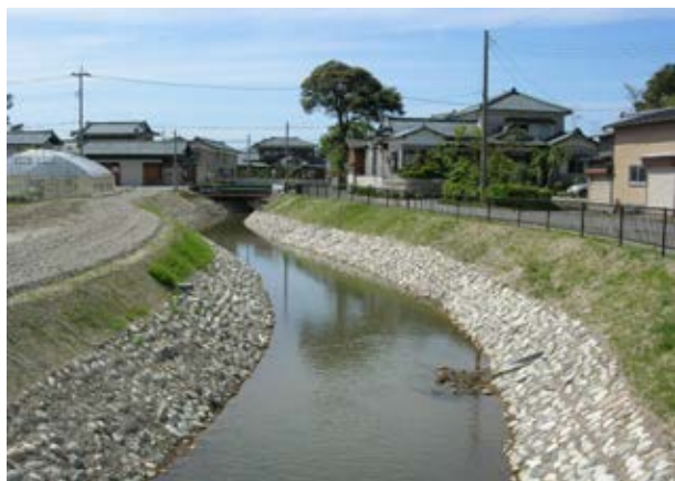
写真-15. 1543 緩勾配型自然石付金網護岸工設置状況
