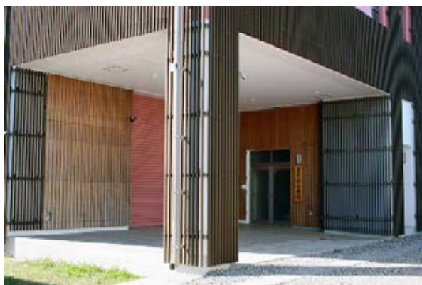
写真-15.9 整備後の排水機場入口部
