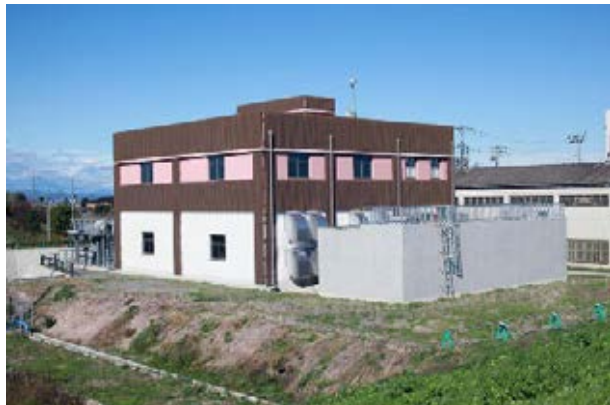
写真-15.8 整備後の排水機場全景
