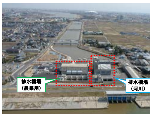
図-16.12 排水機場と周辺の市街地
