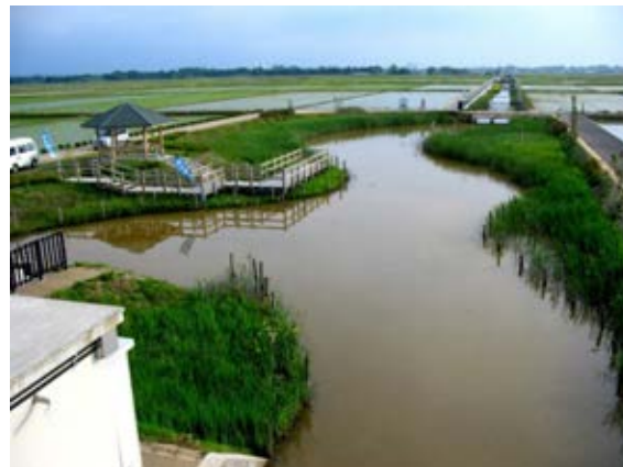
写真-15. 1846 多自然型浄化池設置状況
