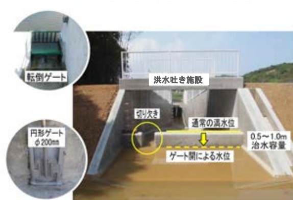
図-16.110 洪水吐き放流ゲート等の設置
