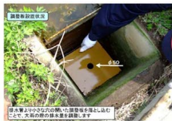
写真-16.1 調整板設置状況
