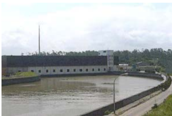
写真-15.6 事業実施前の排水機場
