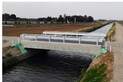
写真-4.4.1 水路横断工として門形カルバートを用いた事例
