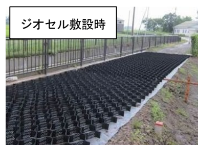
図-4.4.8 ジオセル（ジオセンチックスの一つ）による舗装の例
