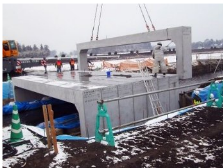
写真-4.4.1 水路横断工として門形カルバートを用いた事例
