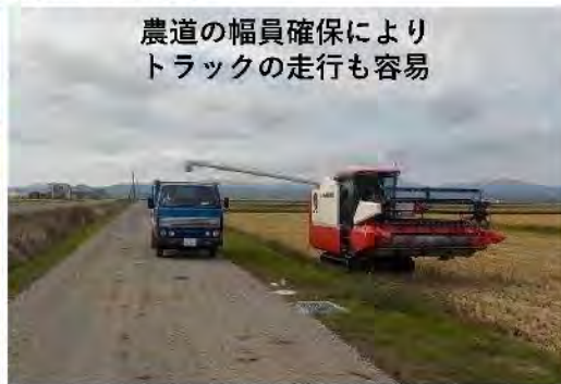
図-3.1.1 用排水路の管路化による農道拡幅事例 2)
