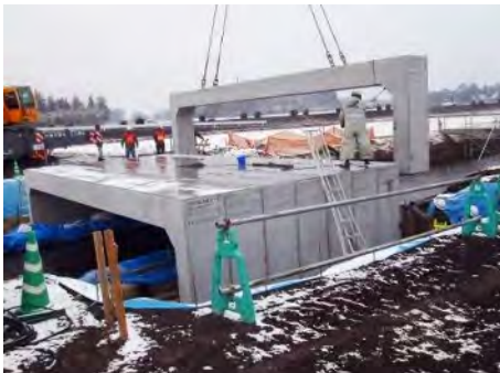
写真-3.4.1 水路横断工として門形カルバートを用いた事例
