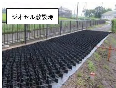
図-3.4.10 ジオセル（ジオセンティックスの一つ）による舗装の例
