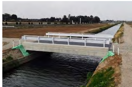
写真-3.4.1 水路横断工として門形カルバートを用いた事例
