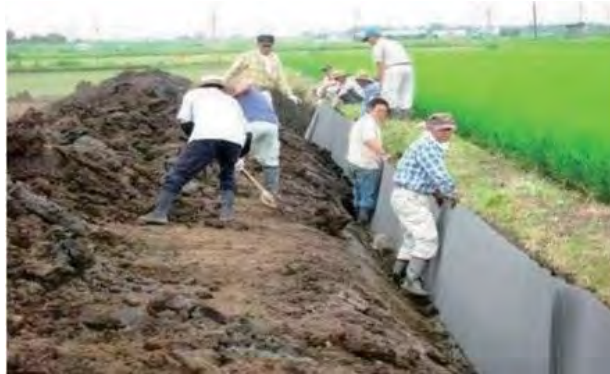
写真-3.8.1 遮水シートの施工事例 1)
