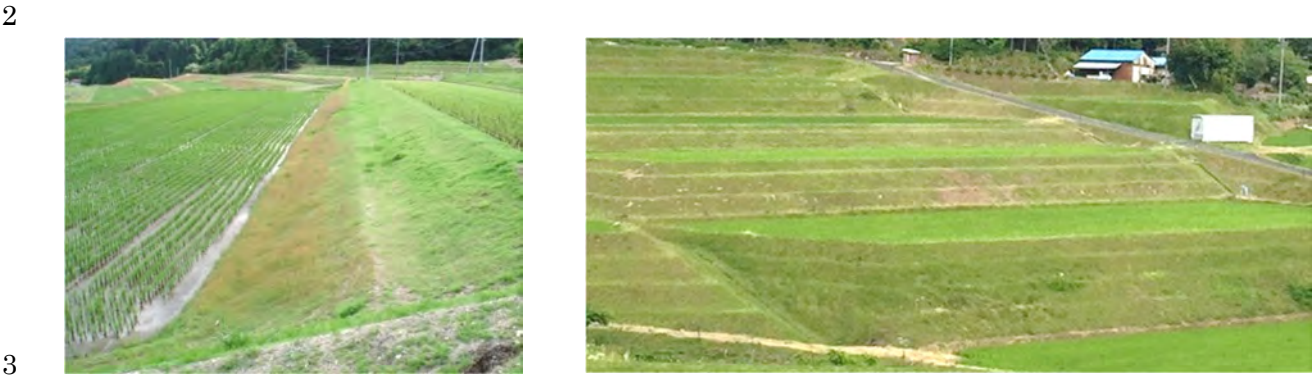
3 写真-4.3.1 地被植物（グランドカバー・プランツ）によって畦畔法面を被覆した事例 4 5
