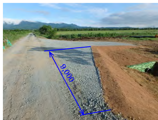
図-4.3.21 進入路の隅切り部分を拡幅した事例
