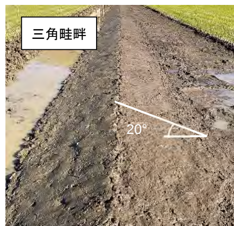
図-4.3.10 リモコン草刈機に対応した畦畔断面
