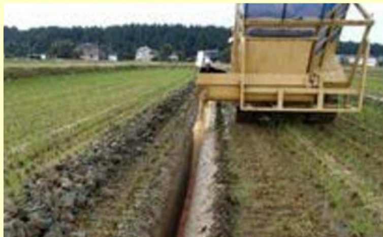
水田下に暗渠排水を設置する様子
