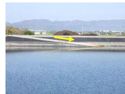
施設内へ下りるスロープの設置例
