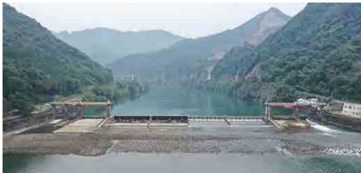
UAV空撮による頭首工全体の点検
