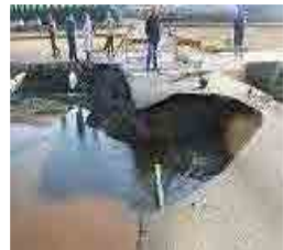
管水路の破裂による道路陥没
