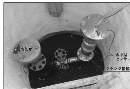
水中型センサー取付例
