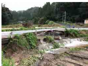
管水路の破裂による営農被害
