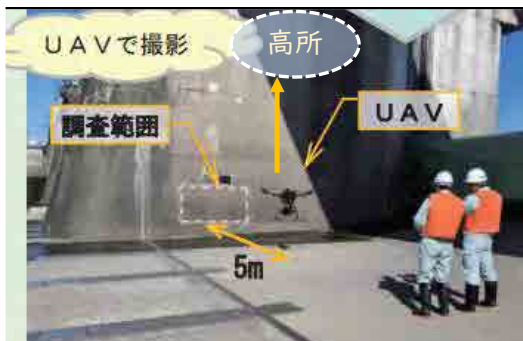
UAVによる頭首工における点検
