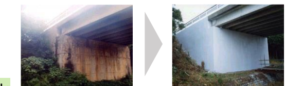
老朽化対策を実施した農道橋
