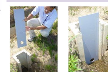
調整板設置状況 排水柵（調整板挿入）（福岡県鯖江市）
