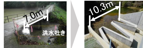
豪雨対策（洪水吐きの改修）の先行整備（例） ※地震対策は豪雨対策完了後に実施
