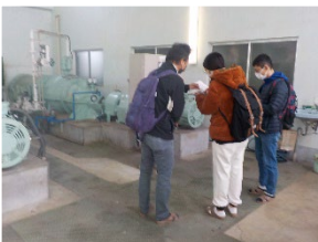
現地調査の様子
