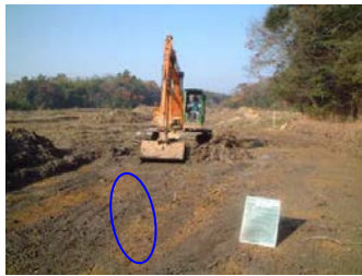
現況表土埋め戻しまでを実施
