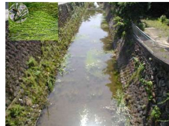
事業実施前の水路
