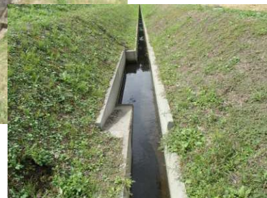
深み工・這い上がりスロープの状況
