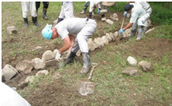
ビオトープの造成 (小浜東部地区 (福井県小浜市))
