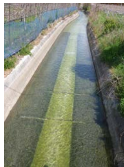
環境配慮対策改善後の水路
