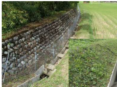
蓋版工の状況
