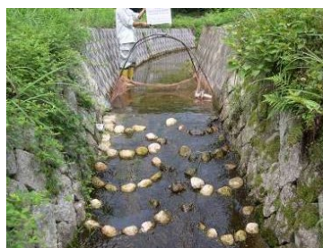
粗石付き斜路型魚道の魚類遡上調査
