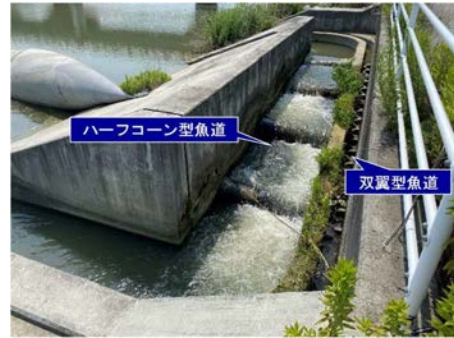
堰樋堰に設置された魚道
