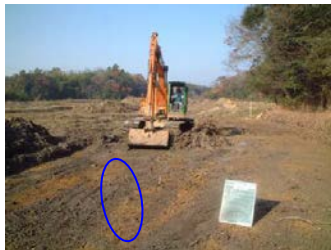
現況表土埋め戻しまでを実施
