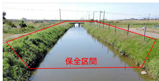
回避された土水路
