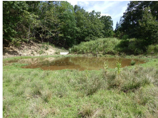
廃止後のため池の状況
