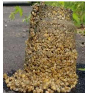
ストレーナーの詰まり
