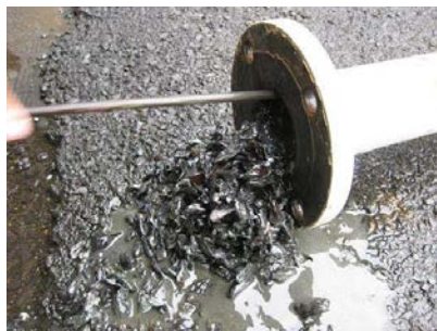
配管の目詰まり
