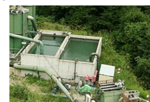
③濁水処理とポンプによる通水
