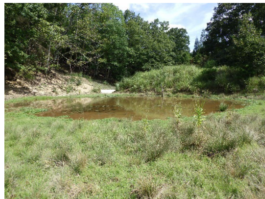
廃止後のため池の状況
