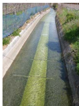
環境配慮対策改善後の水路
