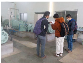
現地調査の様子
