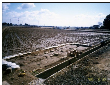
水田を借り入れ沈砂池として利用
