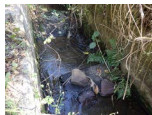
現場打ち魚道
