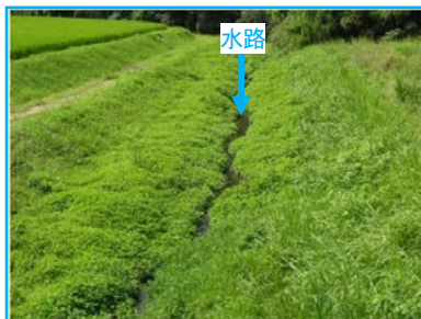
現況水路保全区間
