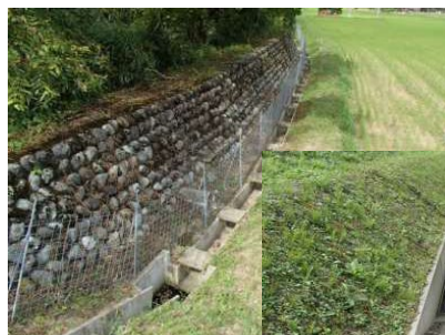
蓋版工の状況
