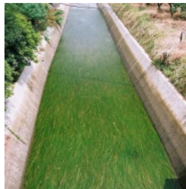
環境配慮対策施工後の水路
