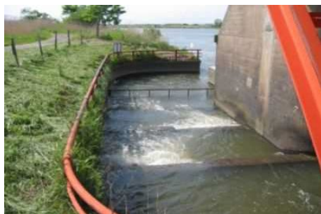
整備前の左岸魚道 （階段式魚道）
