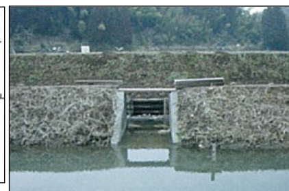
幹線排水路との連続性を確保
