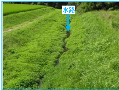
現況水路保全区間
