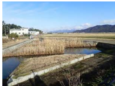
ナガエツルノゲイトウが侵入した循環かんがい施設の浄化池で、水田内に入居するおそれがあることから、送水が止められた事例
