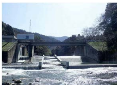
頭首工（改修後）
