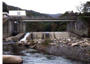
頭首工(改修前)
