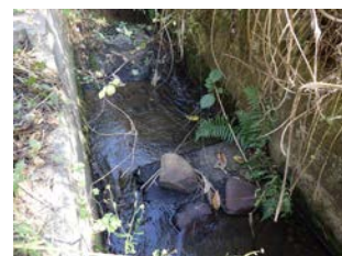
現場打ち魚道
