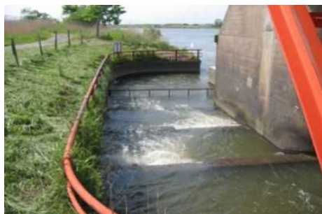
整備前の左岸魚道 (階段式魚道)
