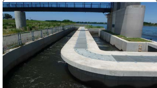
整備後の左岸魚道 (粗石付き斜路型魚道、階段式魚道)
