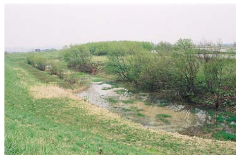
施工後における回避区間の状況
