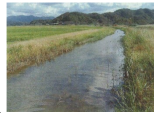
地区を流れる幹線排水路[現況]
