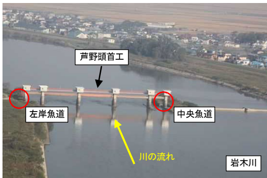
芦野頭首工の状況
